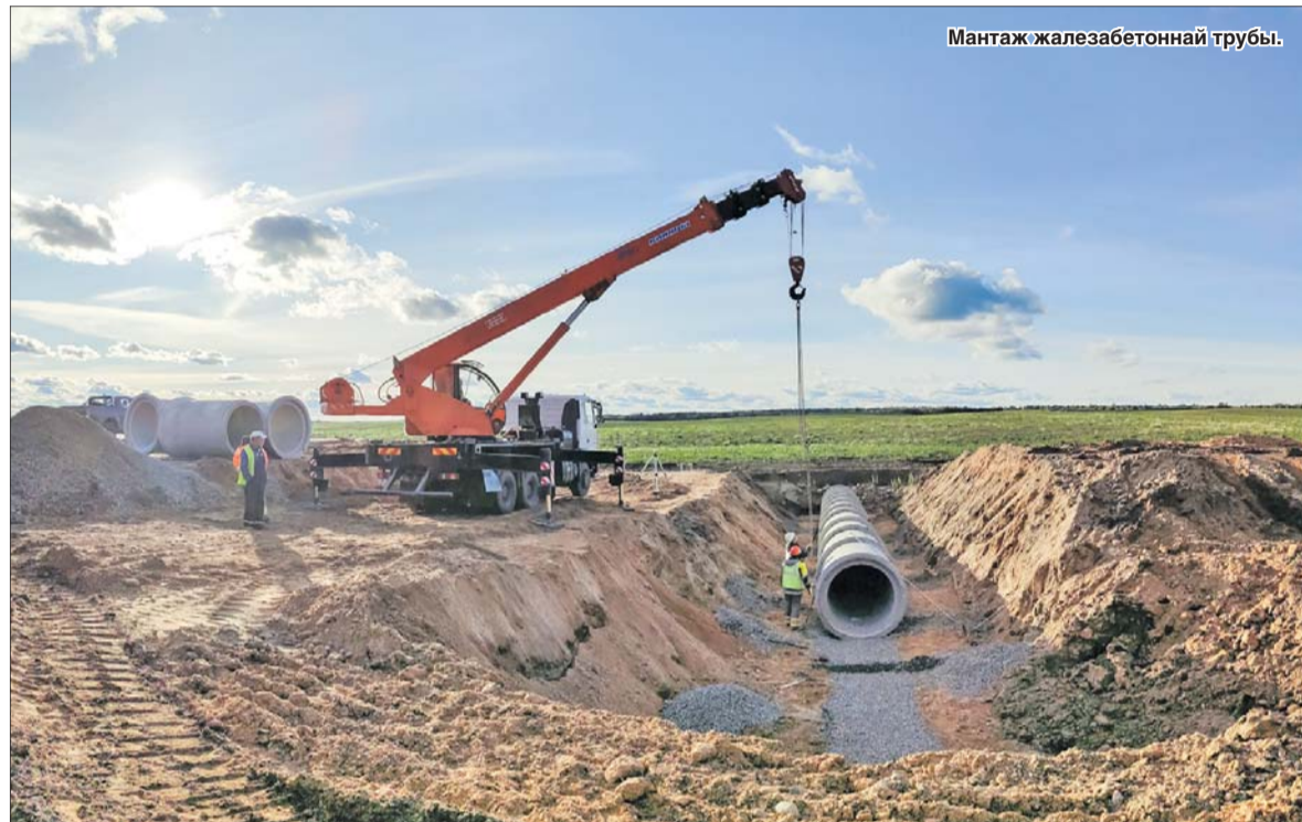
Мантаж жалезабетоннай трубы.
